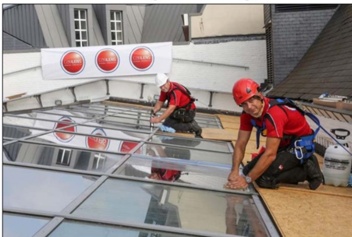
Johan Carlens (vooraan) bekleedt de koepel van het Modemuseum. "De folie houdt niet enkel UV-stralen, maar ook zonne-energie tegen."
